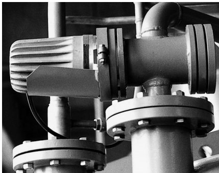
Oprawa oświetleniowa CHEMLUX® typu P 20 DEH M sp., 20 W, 24 V, Ex de IIC T5, Ex tD A21 IP65 T95 ° C, Ex II 2 G + D, zamontowana z opalowego szkła "M" na wskaźniku przepływu medium
